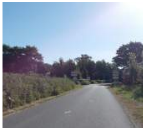
RD 168 – Entrée à hauteur du Portal
