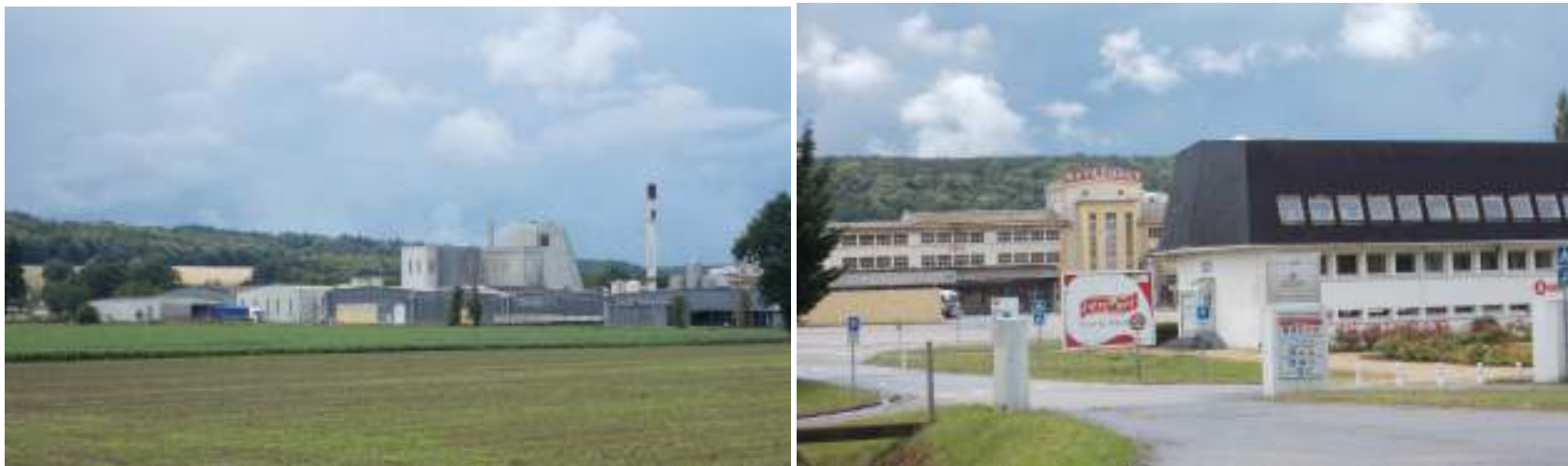
Site de l'Usine Entremont
